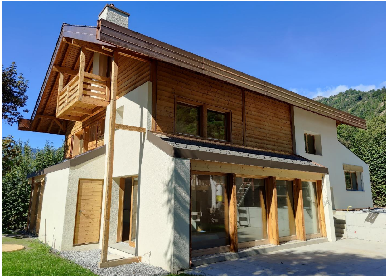
Figure 1: Vues de la villa avant et après travaux
